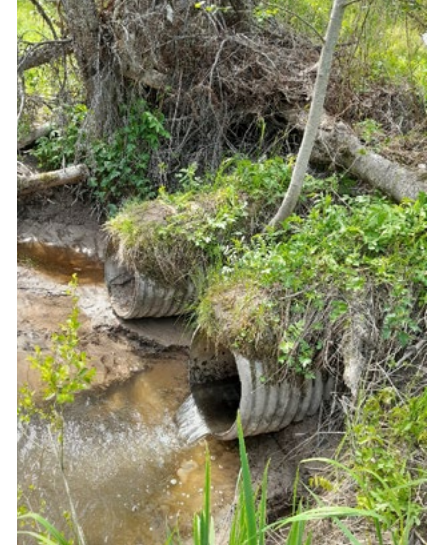
Suurin osa esteistä on tierumpuja, jotka on asennettu liian korkealle tai rummun alapuolinen purouoma on syöpinnyt. Tällöin rummun alapäähän voi muodostua putous, joka estää vesieläimien nousun.
