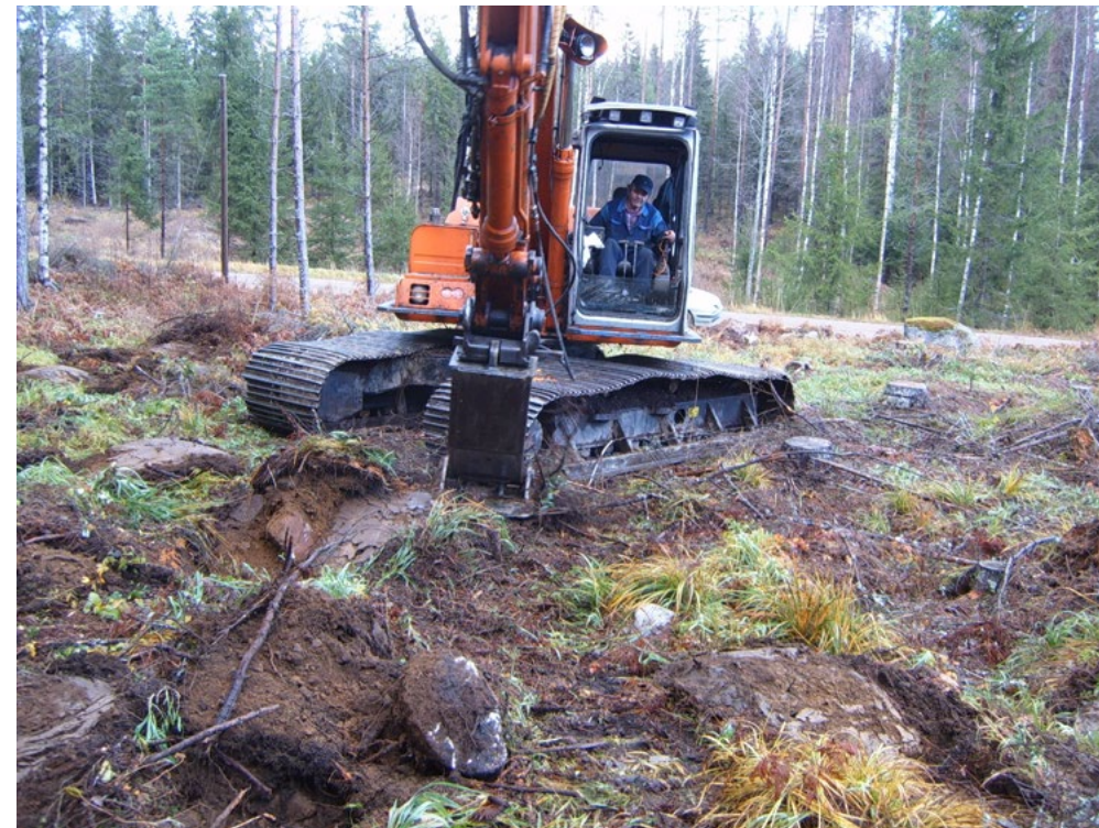
Pienvettä ei tule ylittää koneilla esiintymispaikan kohdalta ja pienveden ylityspaikka esiintymispaikan yläpuolelta tulee valita siten, ettei ylityksestä aiheudu kiintoaineen huuhtoutumista. KUVA: TIMO SILVER
