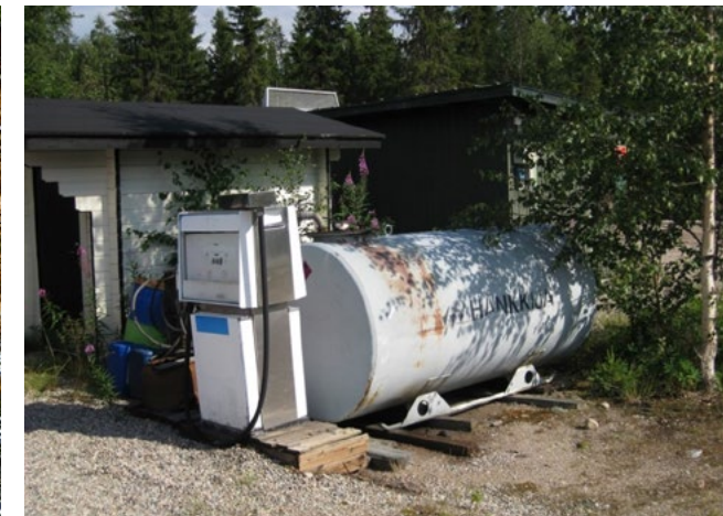
Polttoainesäiliö ja tankkauspaikka on sijoitettava kantavalle täyden säiliön painon kestäväälle alustalle. Säiliön ympärille on jätettävä riittävät suojaetäisyydet rakennuksiin, ojiin ja vesistöihin. KUVA: OLLI HIRSIMÄKI
